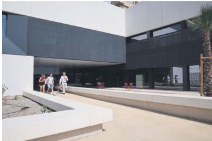
El nuevo centro de salud de Malilla (Valencia), que ha comenzado a funcionar este semana. GVA
